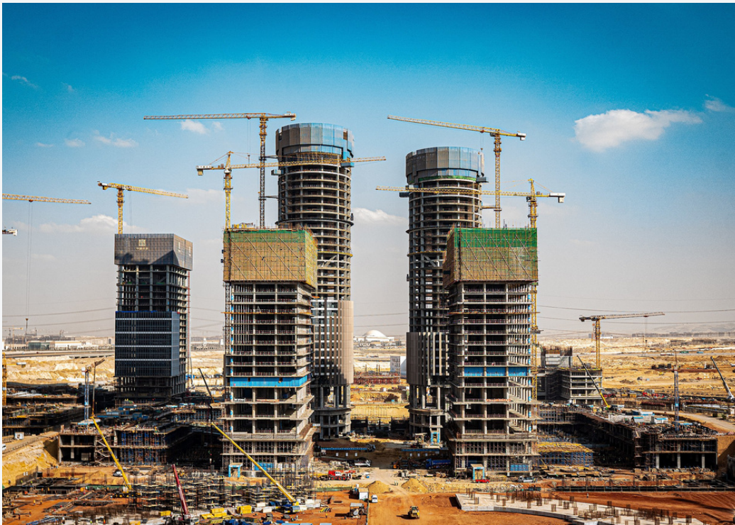
Die Großbaustelle "New Administrative Capital"
